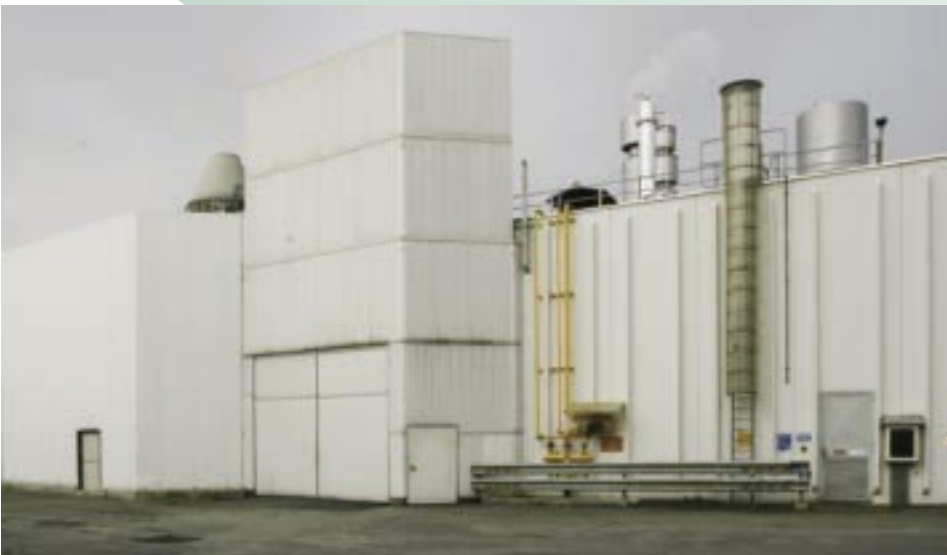
BARRIERE DI INSONORIZZAZIONE DELLO STABILIMENTO SOUNDPROOFING BARRIER FACILITIES
